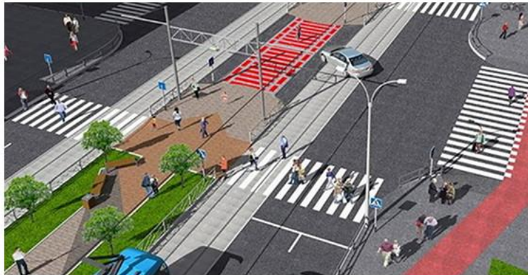
ЗАВЕРШЕННЯ КОМПЛЕКСНОЇ РЕКОНСТРУКЦІЇ ВУЛ. ЗАМОСТЯНСЬКОЇ
