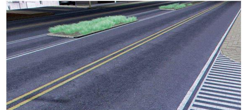
КАПІТАЛЬНИЙ РЕМОНТ ДОРІГ ВУЛИЦЬ: Д.НЕЧАЯ, Л.УКРАЇНКИ, ЧЕРНЯХОВСЬКОГО, Я.ШЕПЕЛЯ, Я.ГАЛЬЧЕВСЬКОГО
