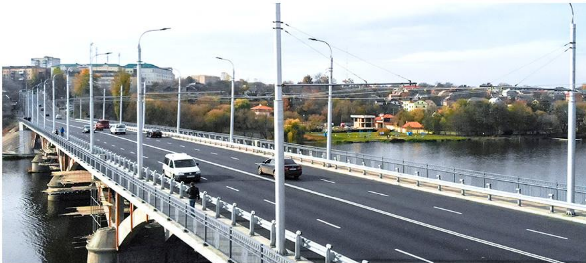
РЕКОНСТРУКЦІЯ МОСТОВОЇ СПОРУДИ ЧЕРЕЗ Р. ПІВДЕННИЙ БУГ
