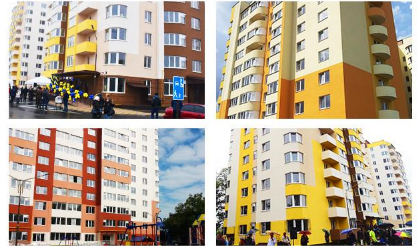
БУДІВНИЦТВО 4 ЖИТЛОВИХ БУДИНКІВ В РАМКАХ ПРОГРАМИ «МУНІЦИПАЛЬНЕ ЖИТЛО ВІННИЦЬКОЇ МІСЬКОЇ ОТГ»
